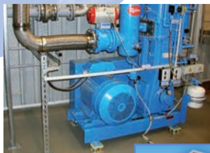
Kompressor, gelagert auf Federisolatoren
